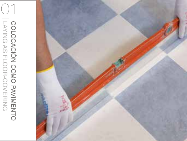
01 EL SOPORTE DEBE SER PERFECTAMENTE PLANO. 01 THE SUPPORT MUST BE PERFECTLY FLAT.
