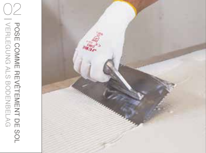
02 APPLIQUEZ LA COLLE AVEC UN DOUBLE ENCOLLAGE SANS LAISSER DE CREUX. D'ABORD AU REVERS DE LA PIÈCE À L'AIDE D'UN PEIGNE À DENTS PLATES DE 3 MM PUIS SUR LE SUPPORT AVEC UN PEIGNE À DENTS INCLINÉES DE 6 MM. EN ESSAYANT DE COUVRIR AUSSI LES ANGLES ET LES BORDS ET D'ÉVITER DES VIDES D'AIR ENTRE LE SUPPORT ET LA PIÈCE. 02 EINE DOPPELTE SCHICHT KLEBER OHNE FREIRÄUME ANBRINGEN, ZUERST AUF DER RÜCKSEITE DER PLATTE MIT EINER GLÄTTKELLE MIT FLACHER ZÄHNUNG (3 MM), ANSCHLIESSEND AUF DEM UNTERGRUND MIT EINER GLÄTTKELLE MIT GENEIGTER ZÄHNUNG (6 MM). DABEI SIND AUCH DIE ECKEN UND RÄNDER ZU BEDECKEN UND LUFTEINSCHLÜSSE ZWISCHEN DEM UNTERGRUND UND DER PLATTE ZU VERMEIDEN.
