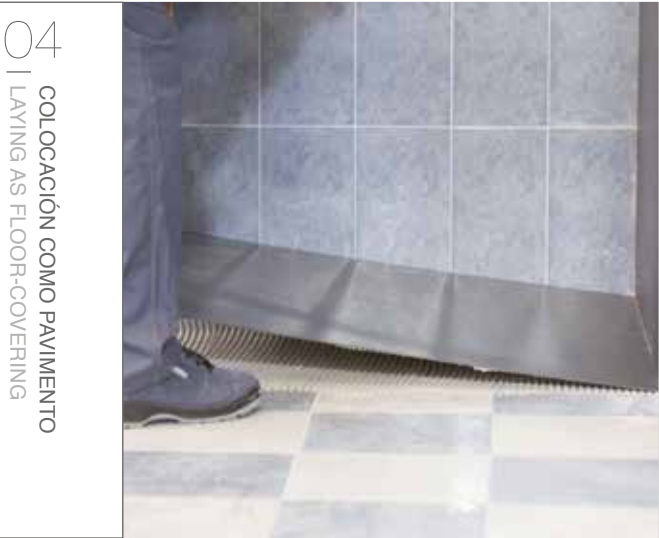
04 APOYAR DELICADAMENTE LA PLACA POR EL LADO LARGO Y, MANTIÉNDOLA LIGERAMENTE INCLINADA, COLOCARLA BAJÁNDOLA Y ADHIRIÉNDOLA AL SOPORTE. 04 DELICATELY SUPPORT THE SHEET ON ITS LONG EDGE, HOLDING IT AT A SLIGHT INCLINATION AND LAY IT BY LOWERING AND ADHERING IT TO THE SUPPORT.
