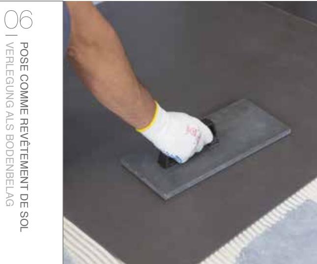
06 FRAPPEZ LA SURFACE EN UTILISANT UNE TRUELLE EN CAOUTCHOUC, EN ESSAYANT D'ÉLIMINER LES CREUX ET LES BULLES D'AIR. VÉRIFIEZ TOUJOURS L'ADHÉRENCE PARFAITE DES ANGLES ET DES ARÊTES. NE MARCHEZ PAS SUR LE REVÊTEMENT DE SOL PENDANT ET APRÈS LA POSE, RESPECTEZ LES TEMPS INDICUÉS PAR LE FABRICANT DE LA COLLE. 06 DIE FLÄCHE MIT EINER GUMMIKELLE ABKLOPFEN, UM HOHLRÄUME UND LUFTBLASEN ZU ENTFERNEN. IMMER DIE PERFEKTE HAFTUNG VON ECKEN UND KANTEN ÜBERPRÜFEN. DEN BODENBELAG WÄHREND UND NACH DER VERLEGUNG NICHT BETRETEN UND DIE VOM HERSTELLER DES KLEBERS ANGEgebenEN ZEITEN EINHALTEN.
