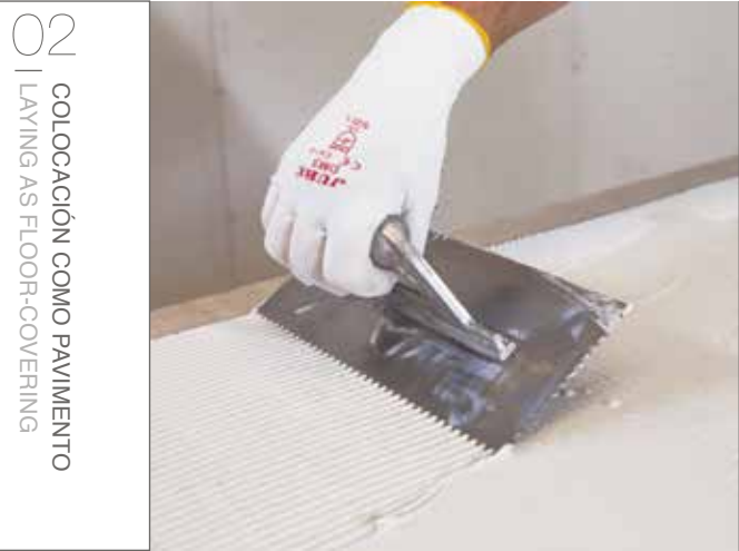
02 APLICAR EL ADHESIVO CON UN DOBLE ENCOLADO SIN DEJAR HUECOS, PRIMERO EN EL REVERSO DE LA PIEZA CON UNA LLANA DE DIENTES PLANOS DE 3 MM Y A CONTINUACIÓN EN EL SOPORTE CON UNA LLANA DE DIENTES INCLINADOS DE 6 MM. PROCURANDO CUBRIR TAMBIÉN LAS ESQUINAS Y LOS BORDES Y EVITAR VACÍOS DE AIRE ENTRE EL SOPORTE Y LA PIEZA. 02 APPLY THE ADHESIVE TO BOTH SURFACES WITHOUT LEAVING GAPS, FIRST TO THE BACK OF THE PIECE USING A FLOAT WITH FLAT 3 MM TEETH AND THEN TO THE SUPPORT USING A FLOAT WITH INCLINED 6 MM TEETH, TAKING CARE TO COVER THE CORNERS AND EDGES AND AVOIDING AIR-GAPS BETWEEN THE SUPPORT AND THE PIECE.
